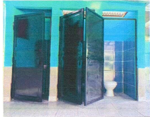
Foto 4: Mejoramiento e instalación de puertas y sanitarios.
