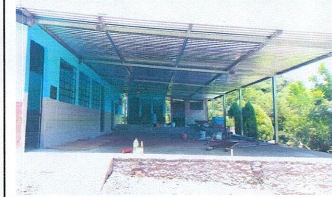
Foto 1: Mejoramiento y reparación de techo de aula, dirección y bodega.
